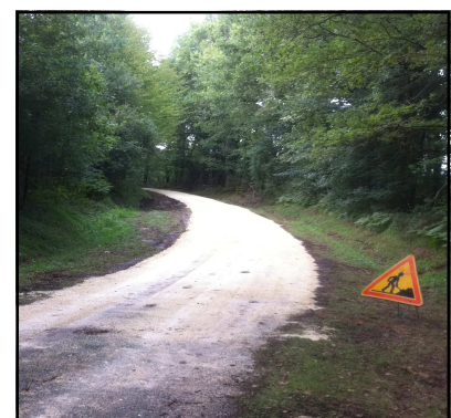
Réfection de la chaussée
